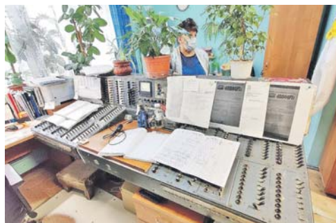
Действующий аналоговый пульт типа ПДЛ-320 с высоким процентом износа производства 1970-х
